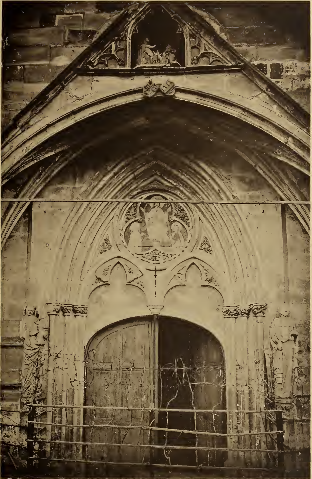
Fig. 109. WORMS Liebfrauenkirche : Südportal.
